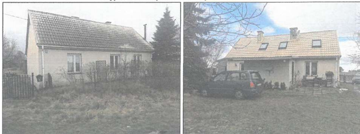
Zdjęcia 8-9: Budynek mieszkalny na działce 286/1.
