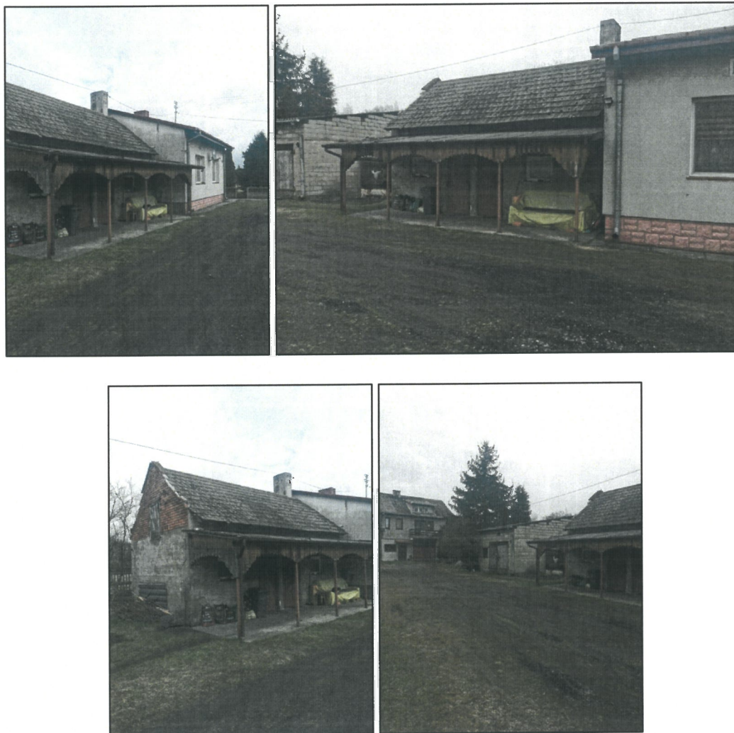
Zdjęcia 17-20: Budynki gospodarcze usytuowane wzdłuż północnej granicy działki.
