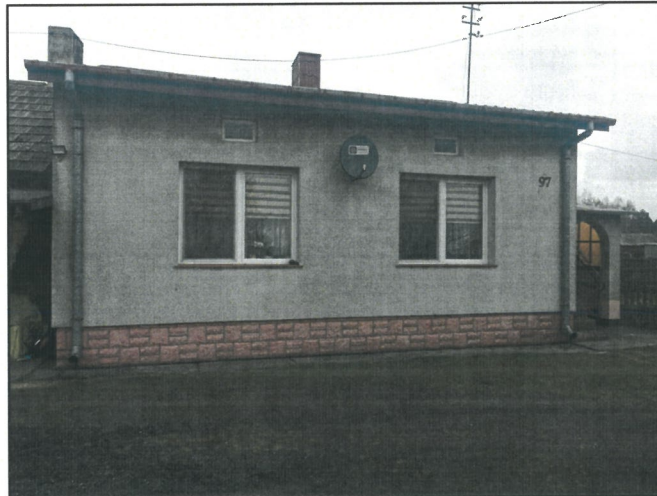
Zdjęcie 9: Budynek mieszkalny.
