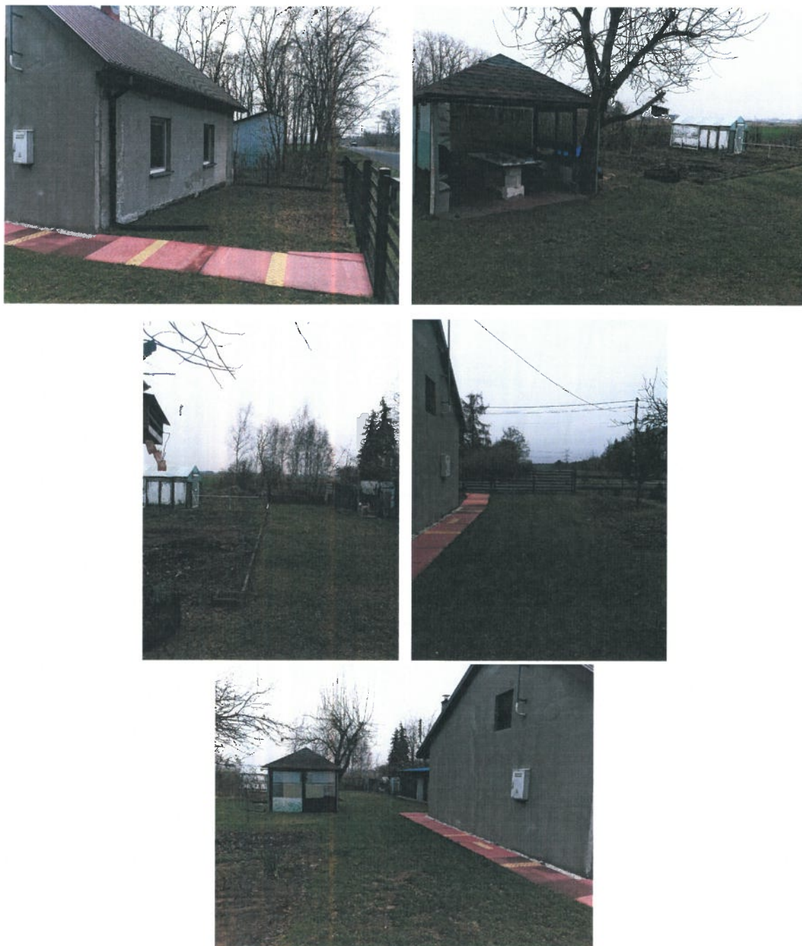
Zdjęcia 3-7: Stan zagospodarowania terenu.
