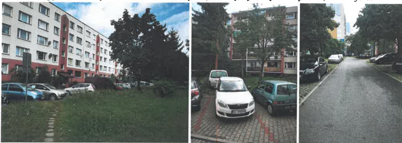
Zdjęcia 1-3: Bezpośrednie otoczenie budynku, w którym jest wyceniany lokal, oraz dojazd.
