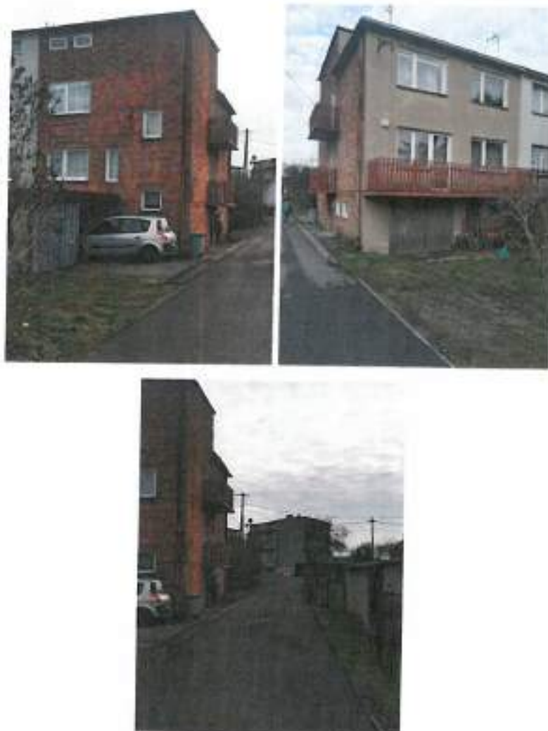
Zdjęcia 3-5: Stan zagospodarowania terenu.
